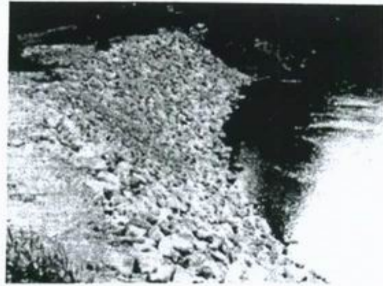
شکل (۳): نمونه یک سنگچین محافظ (Rip Rap)
